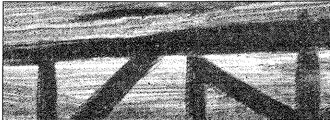
Eşek Köprüsü'nden detaylar
